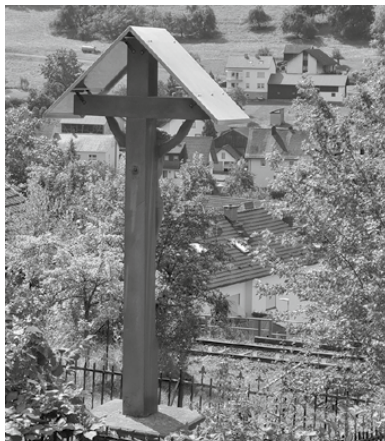
Neues Kupferdach auf dem Wegkreuz Im Seifen
