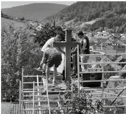
Montage des Kupferdaches auf dem Wegkreuz Im Seifen
