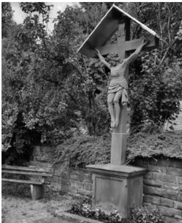
Neues Kupferdach auf Wegkreuz Rippberger Straße
