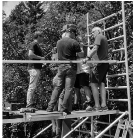
Montage des Kupferdaches auf dem Wegkreuz Rippberger Straße
